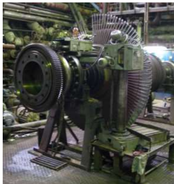
Южная ТЭЦ, замена рабочих лопаток последней ступени ротора турбины К-50-90 ЛМЗ
